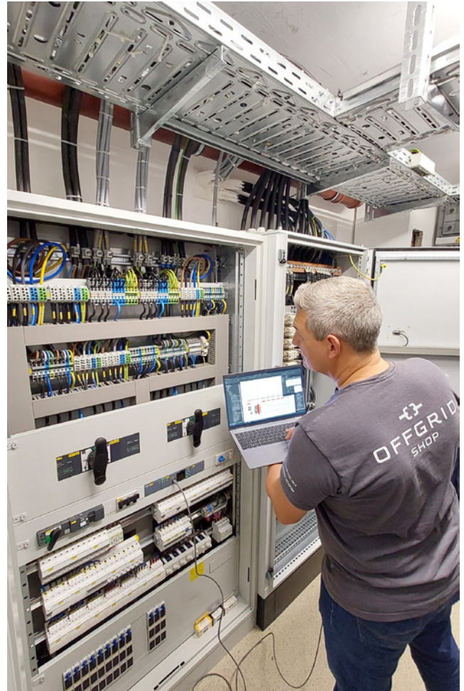
Die Montage erfolgt computer-gestützt mithilfe der zuvor in WSCAD erzeugten Dokumentation
