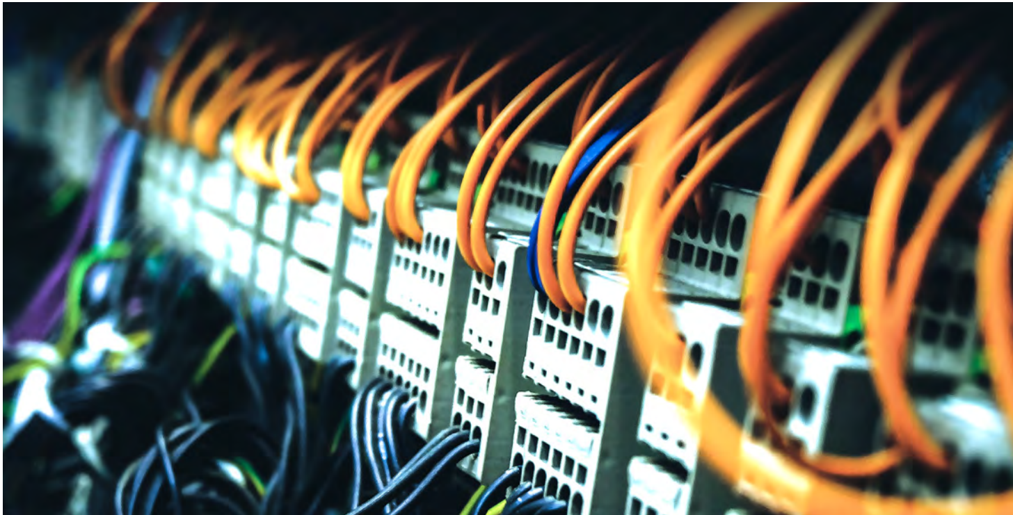
Füllgradberechnung und Kollisionsprüfung mit WSCAD Cabinet Engineering bei der Schaltschrankplanung
